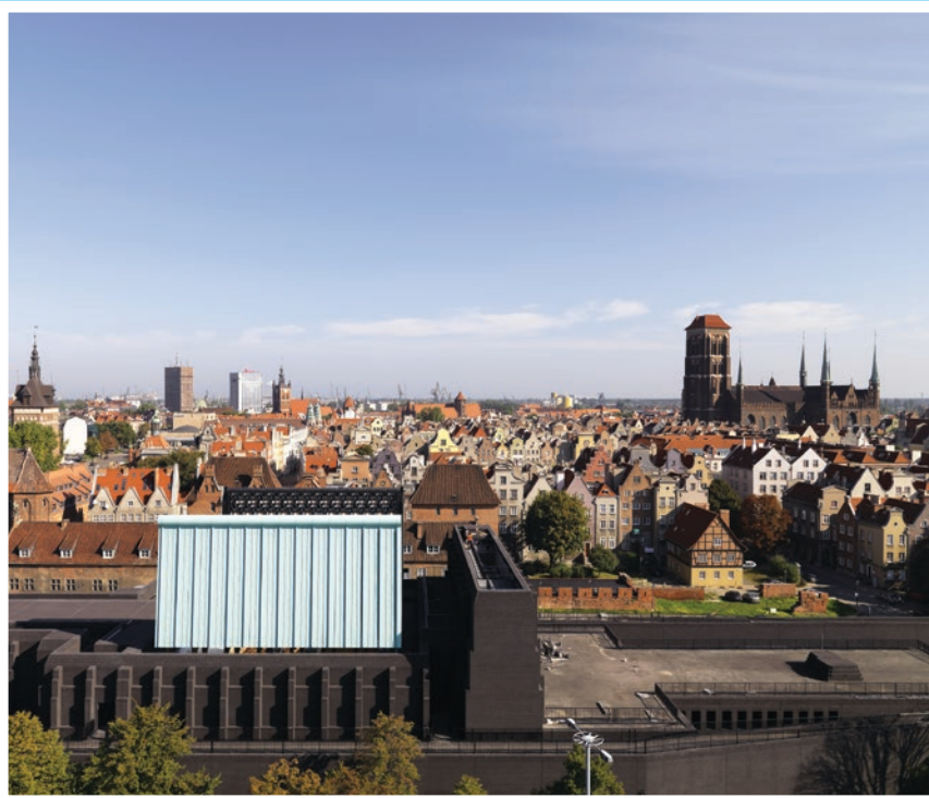
Il. 23. Widok bryły Teatru Szekspirowskiego, widzianej od strony południowej; uwagę zwraca otwarty seledynowy dach (fot. Matteo Piazza)
